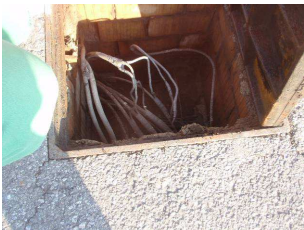
Esempi di linea interrata posata in canalizzazione con pozzetto in cemento nell'impianto di proprietà Enel Sole;
