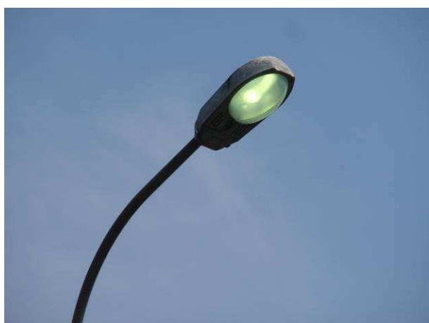
Apparecchi stradali di tipo chiuso con sorgente luminosa a vapori di mercurio HG AP, NON CONFORMI;
