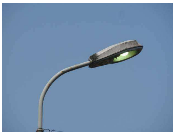
Apparecchi stradali di tipo chiuso con sorgente luminosa a vapori di mercurio HG AP, NON CONFORMI;
