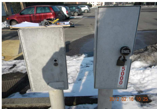
Contenitori per gruppo di misura e quadro di comando;
