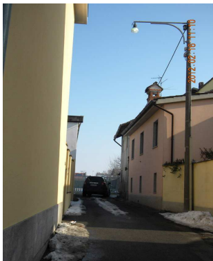
Centro luminoso con APPARECCHIO NON CONFORME;
