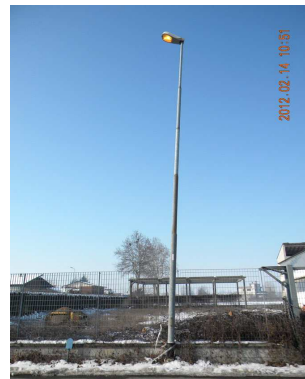
Centro luminoso con SOSTEGNO DA SOSTITUIRE;
