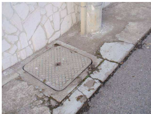
Esempi di linea interrata posata in canalizzazione con pozzetto in cemento nell'impianto di proprietà Enel Sole;
