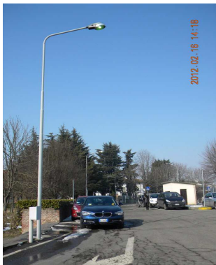
Centro luminoso con APPARECCHIO NON CONFORME;
