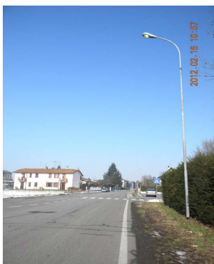
Centro luminoso con APPARECCHIO NON CONFORME;
