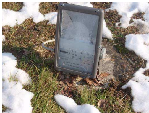
Proiettore da schermare per renderlo CONFORME;
