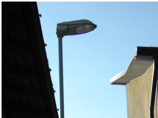
Centro n°0274 - Via Vignazza, apparecchio con sorgente luminosa NON CONFORME , da revisionare;
