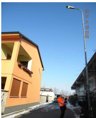
Centro luminoso con APPARECCHIO NON CONFORME;
