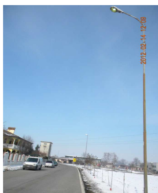
Centro luminoso con APPARECCHIO NON CONFORME;
